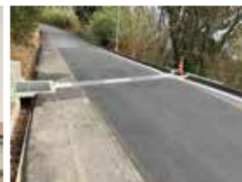
土砂崩れを繰り返す坂道の排水性改善工事
