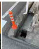
歩道に車道防止コーン設置
