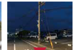
高遮りに街灯設置
