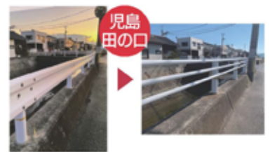
ドライバーの視界を妨げるガードレールをパイプに変更
