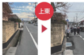
通学路側溝の暗渠化
